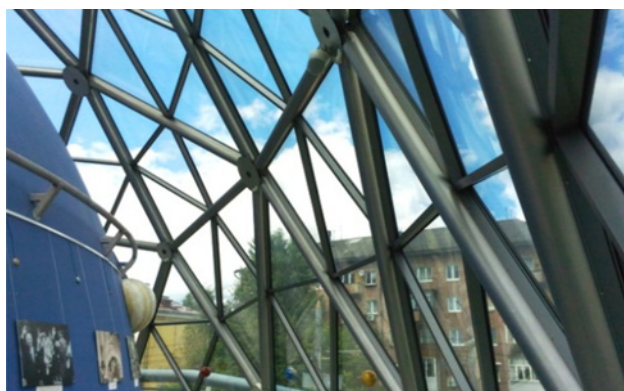
Рис. 11. Вид конструкции купола изнутри
