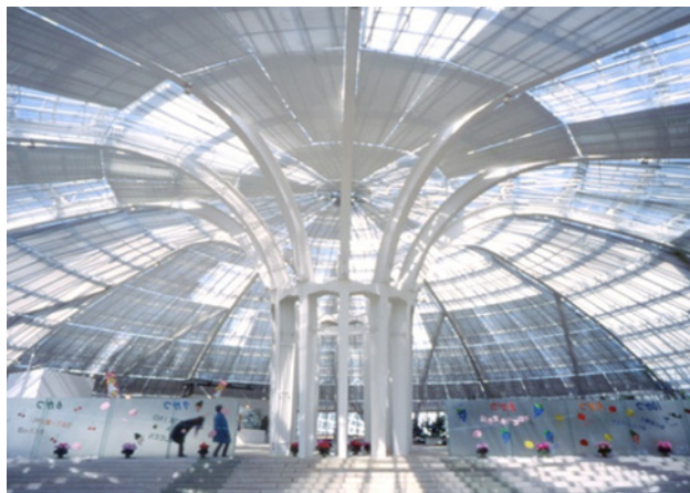
Рис. 9. Купол с упрочнением в виде жесткой конструкции
