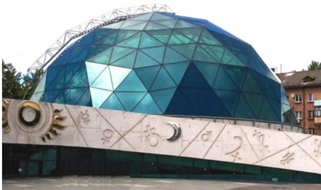
Рис. 10. Купол с внешней поверхностью, собранной из треугольников
