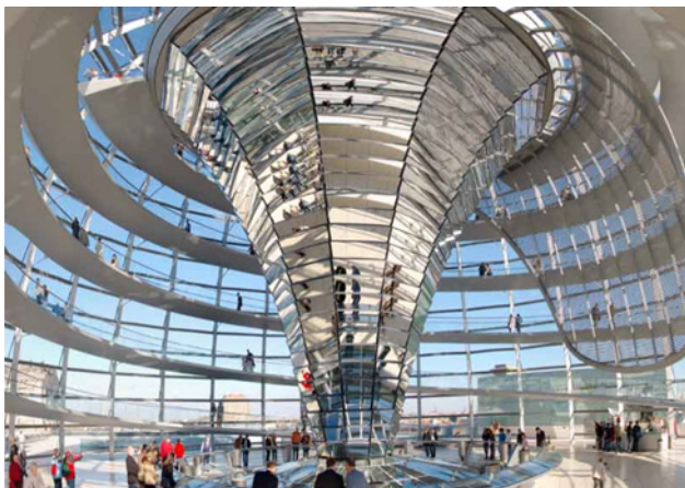
Рис. 8. Купол с упрочняющим столбом-оболочкой
